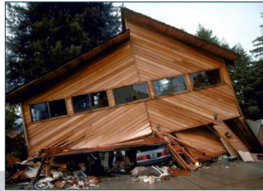
1989 Loma Prieta EQ
