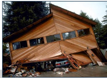
1989 Loma Prieta EQ
